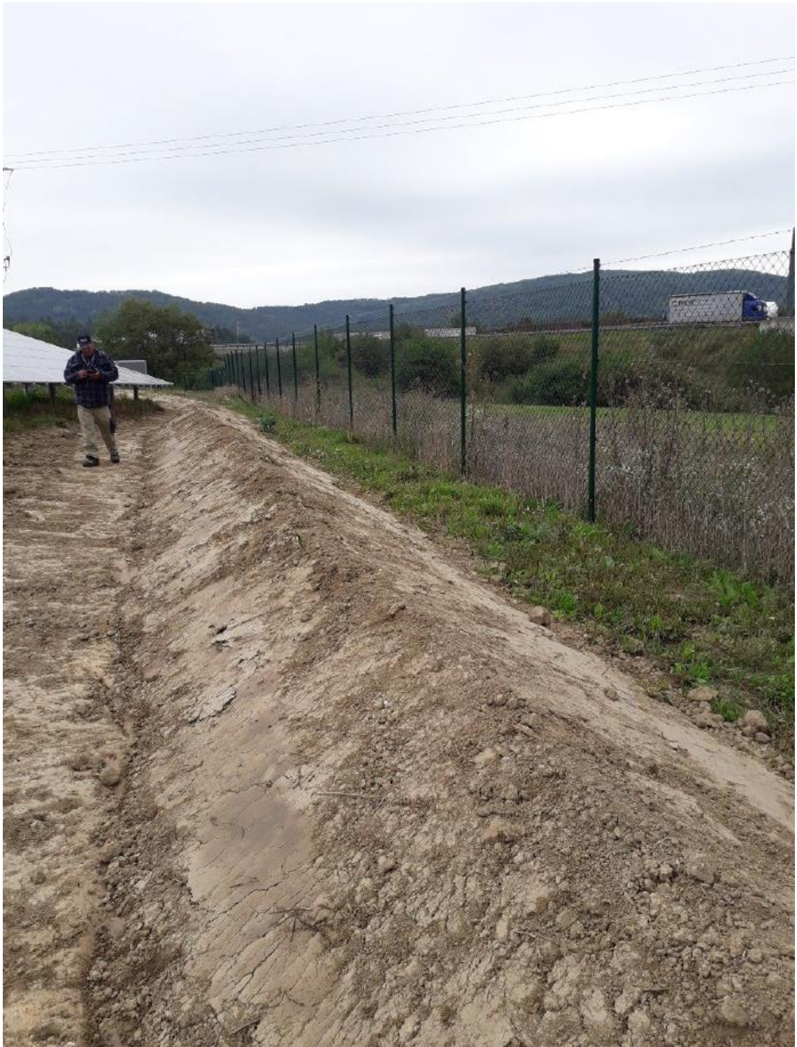
Abb. beabsichtigte Verwallung zur Verbesserung der Rückhaltung
